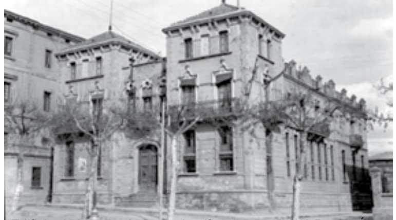
Edificio de la escuela normal unificada que dirigió Pepita Úriz
